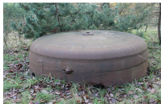
Fig. 44 – Foto af tårnet udvendigt. Området omkring tårnet er afspærret. Foto: Achim Otto, 2019
