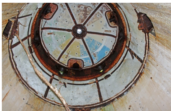
Fig. 43 – Et kig op i det indre af tårnet. Øverste platform er demonteret og væk. Foto: Achim Otto, 2019
