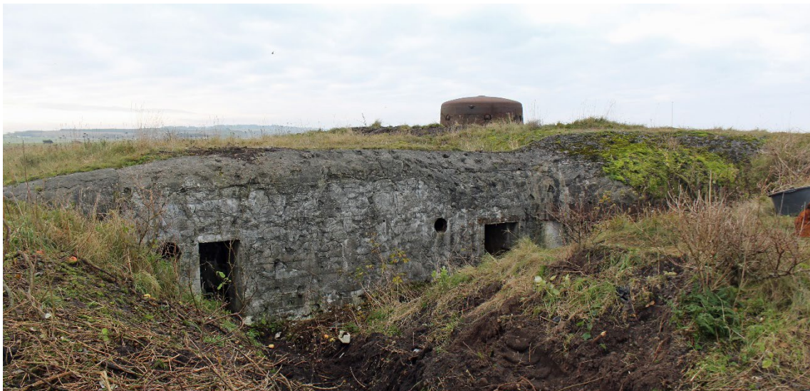
Fig. 34 – Bunkeren efter registreringen. Tårnet er fritlagt som det tog sig ud under krigen. Foto: Achim Otto, 2019
