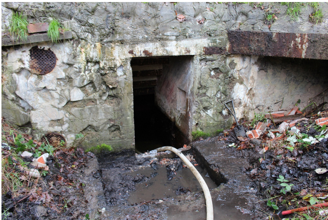
Fig. 39 – Åbnet og fritlagt indgang til bunkeren. Foto: Achim Otto, 2019
