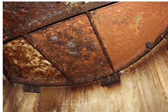
Fig. 42 – Underside gulv i mellemlplattformen. Foto: Achim Otto, 2019
