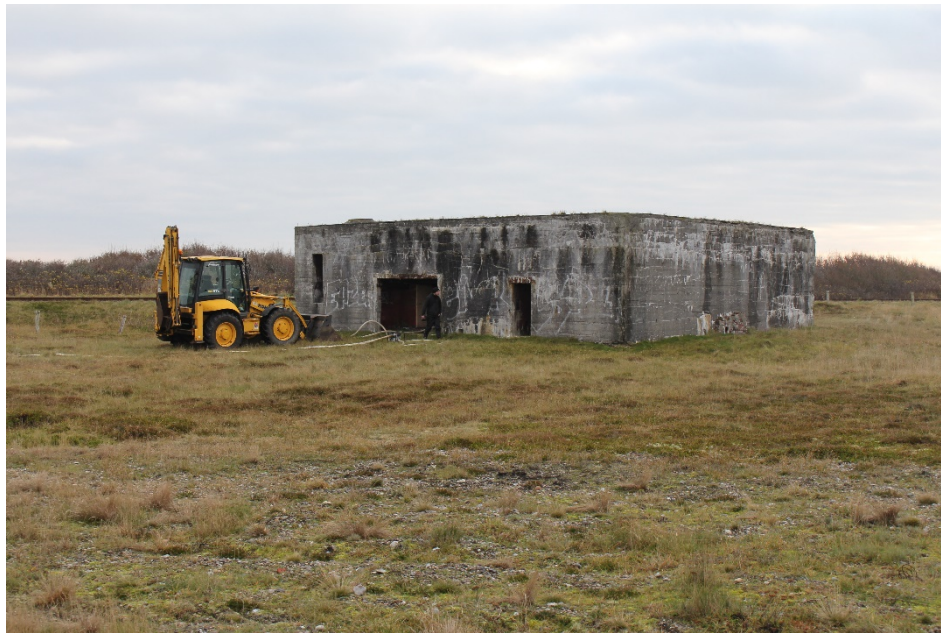
Fig. 37 – Foto af bunkeren type 629 set ude fra. Foto: Achim Otto, 2019
