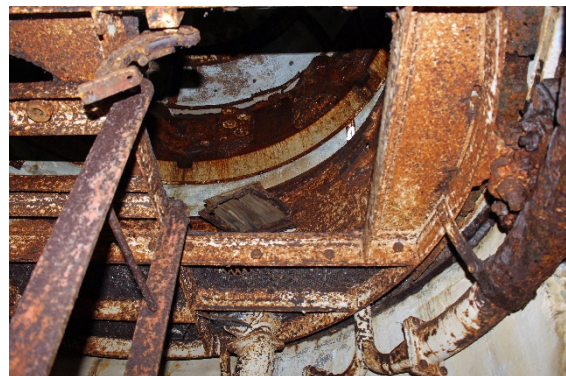
Fig. 36 – Et kig op i tårnet fra mellemste platform. Foto: Achim Otto, 2019
