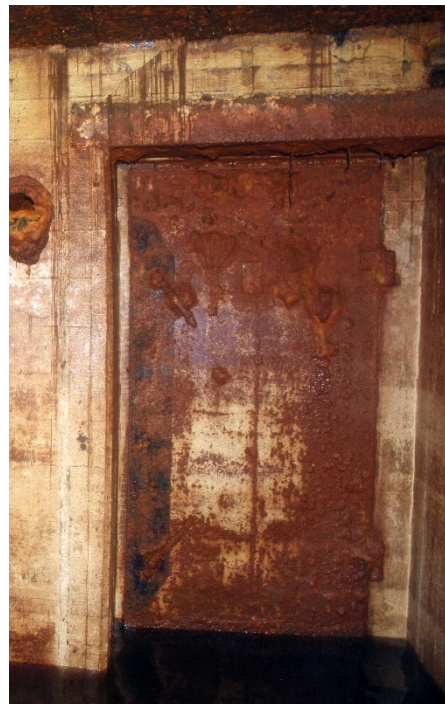
Fig. 25 – Rustmedtaget dør, mellem mandskabsrum. Døren var fuldt funktionsdygtig og fik kort efter udpumpning af vandet, en smøring. Døren er af marinetypen 'T17'. Foto: Achim Otto, 2019
