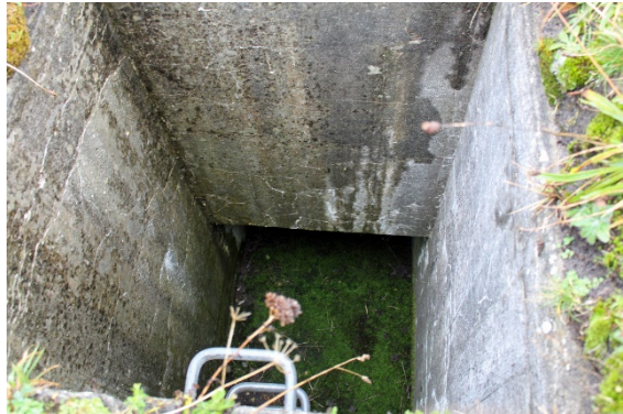
Fig. 33 – Et kig ned i skakten for nødudgangen. Foto: Achim Otto, 2019
