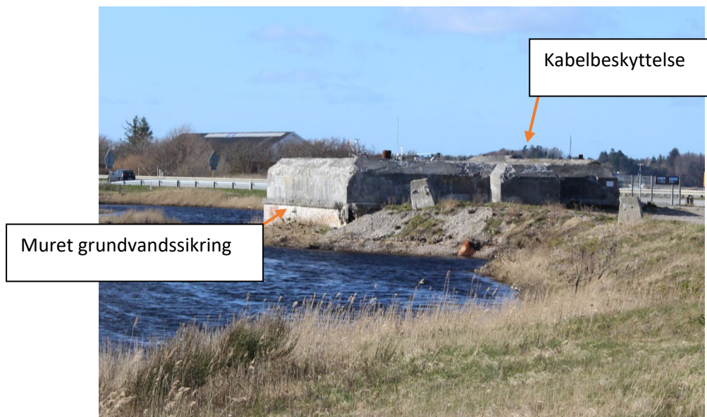
Fig. 18 - L411A Oddesund Nord - "Klodsen" i gavlen og synlig grundvandssikring på bagsiden. Foto: Morten Jensen, 2019
